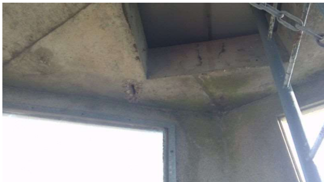
Epaufure au plafond à réparer.
